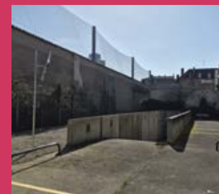
Désherbage, installations d'arceaux et d'un miroir de sécurité, marquage au sol.
