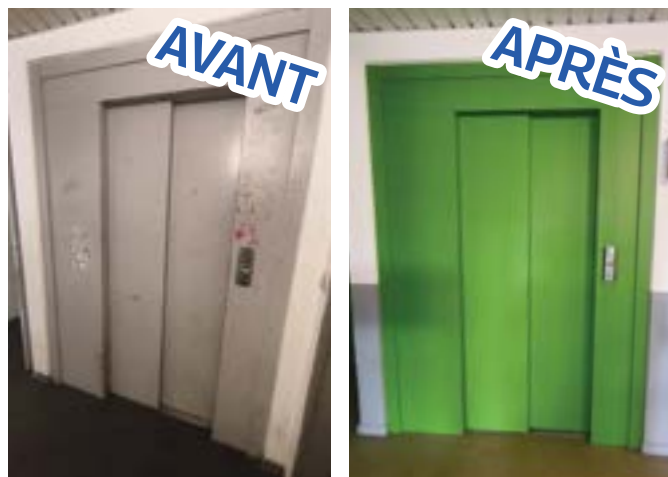
Remise en état de l'ascenseur.
