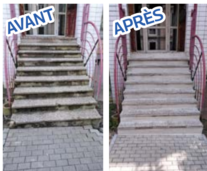
Nouvelles marches d'escaliers et garde-corps sécurisés - 14 entrées.
