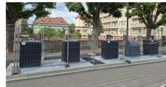
Points d'apport volontaires, sécurisés avant leur mise en service.
