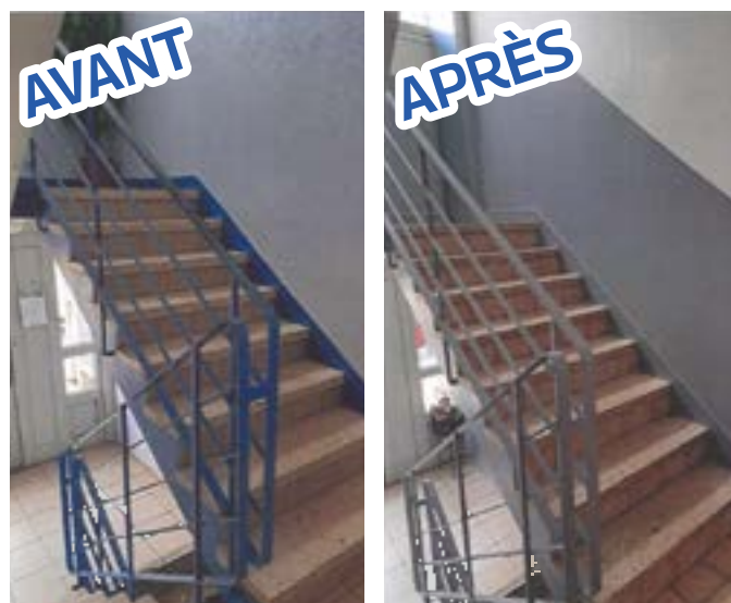
Remise en peinture des cages d'escaliers.
