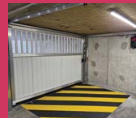
Remise en fonction de la porte automatique et marquage au sol.
