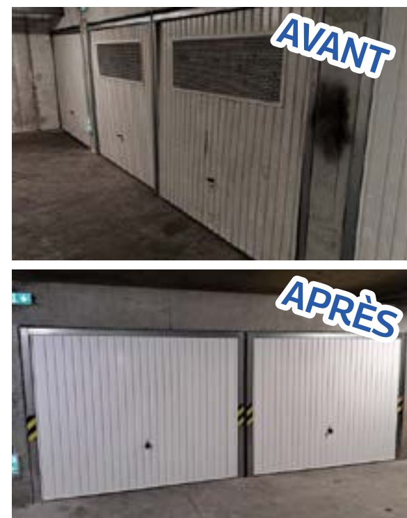
Remplacement des portes de garages.
